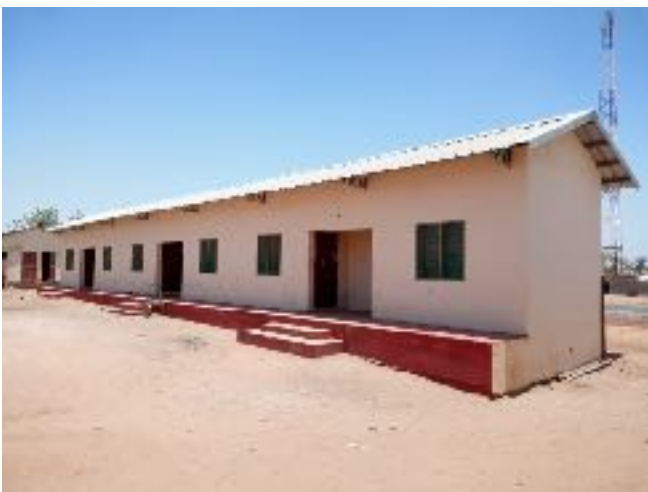
Renovatie personeelswoningen Sami Pachonki.
